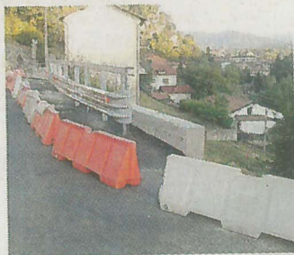
Il muro appena ultimato
